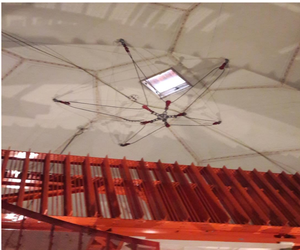
Rysunek 1. Konstrukcja linowa radar ASR10
