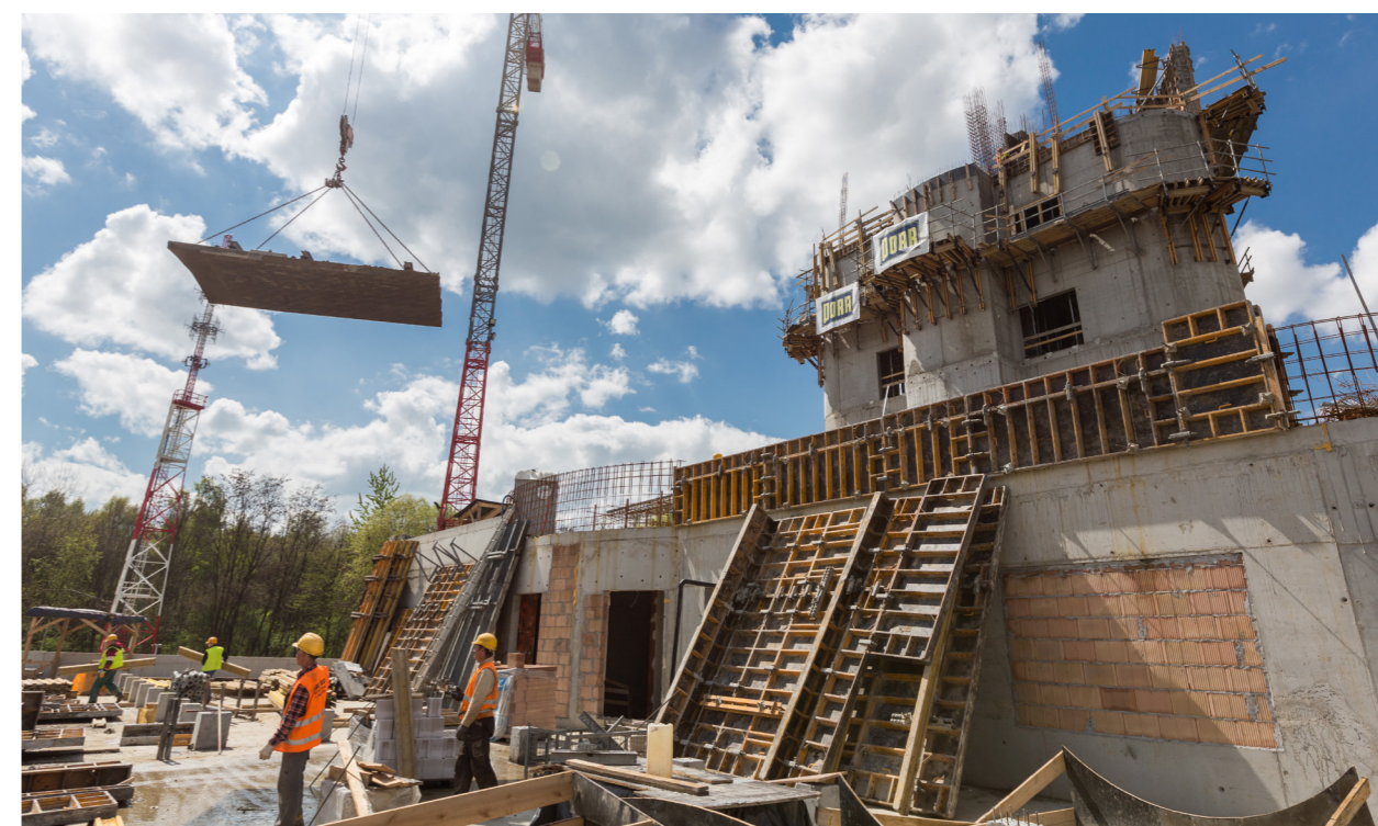
Budowa TWR w Krakowie
