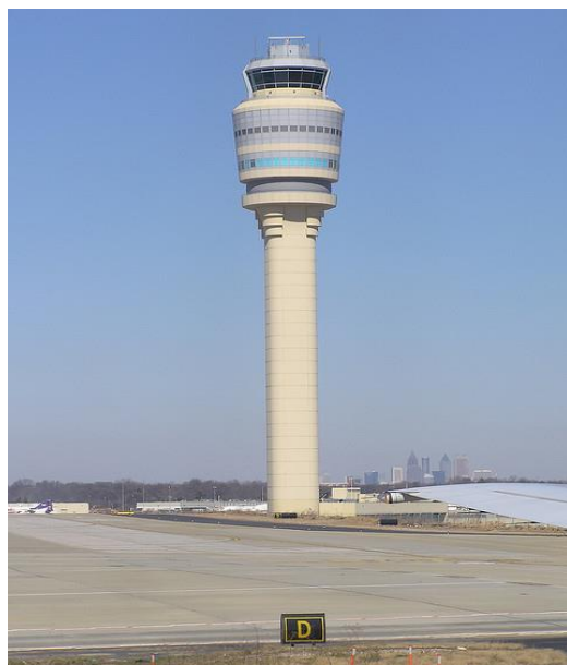
Przykład wieży kontroli ruchu lotniczego
