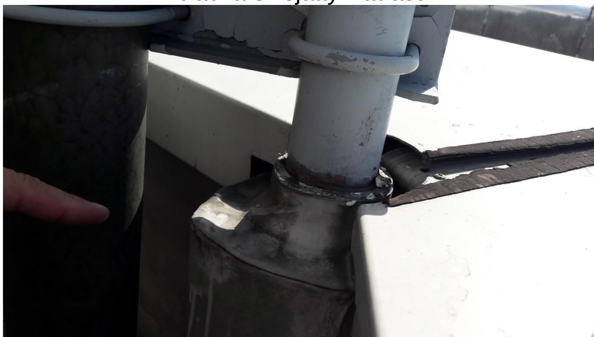
Zdjęcie nr 4. - Roznitowane połączenie obróbki blacharskiej attyki tarasu.
