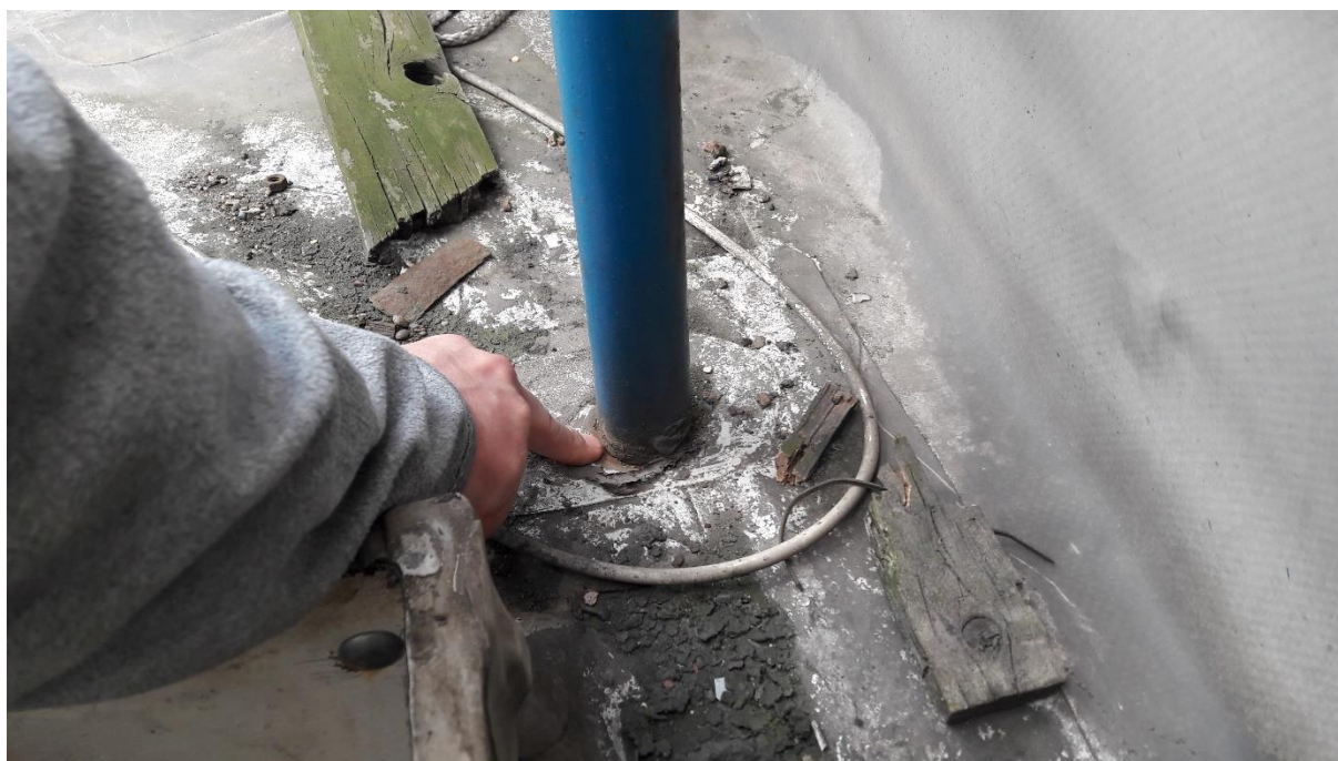
Zdjęcie nr 4. - Roznitowane połączenie obróbki blacharskiej attyki tarasu.
