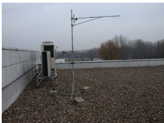
Dach sektora „B”
