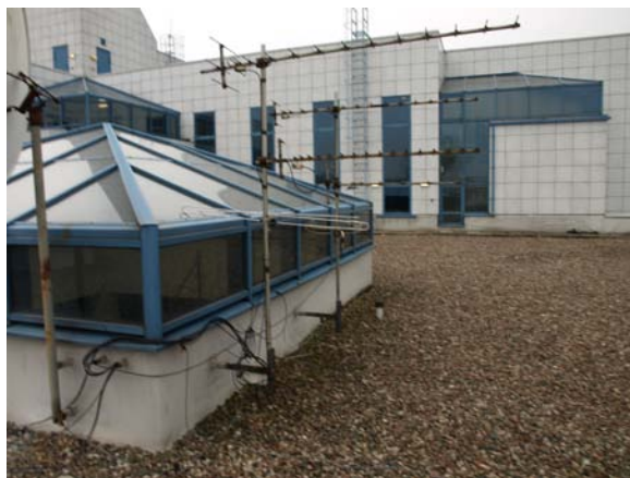
Dach sektora „E”
