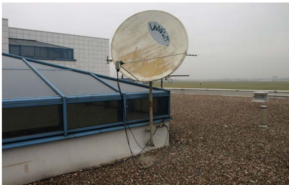
Dach sektora „E”
